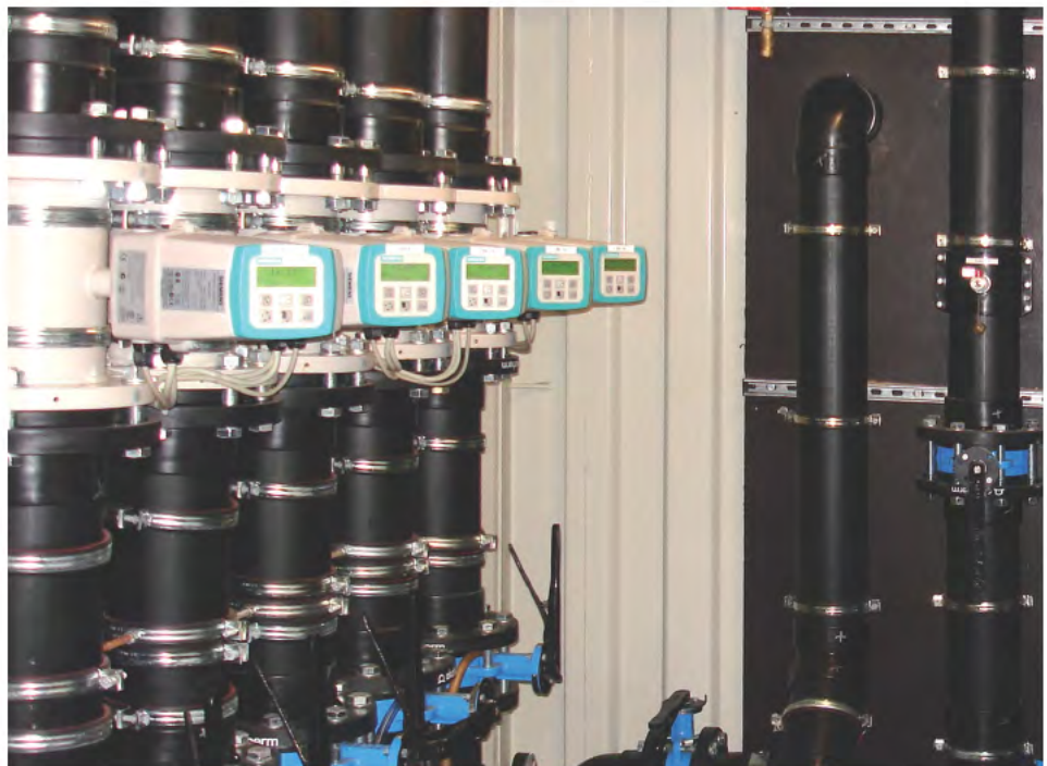
MID-Galerie zur Erfassung der Grundwasserförderraten der Einzelbrunnen
