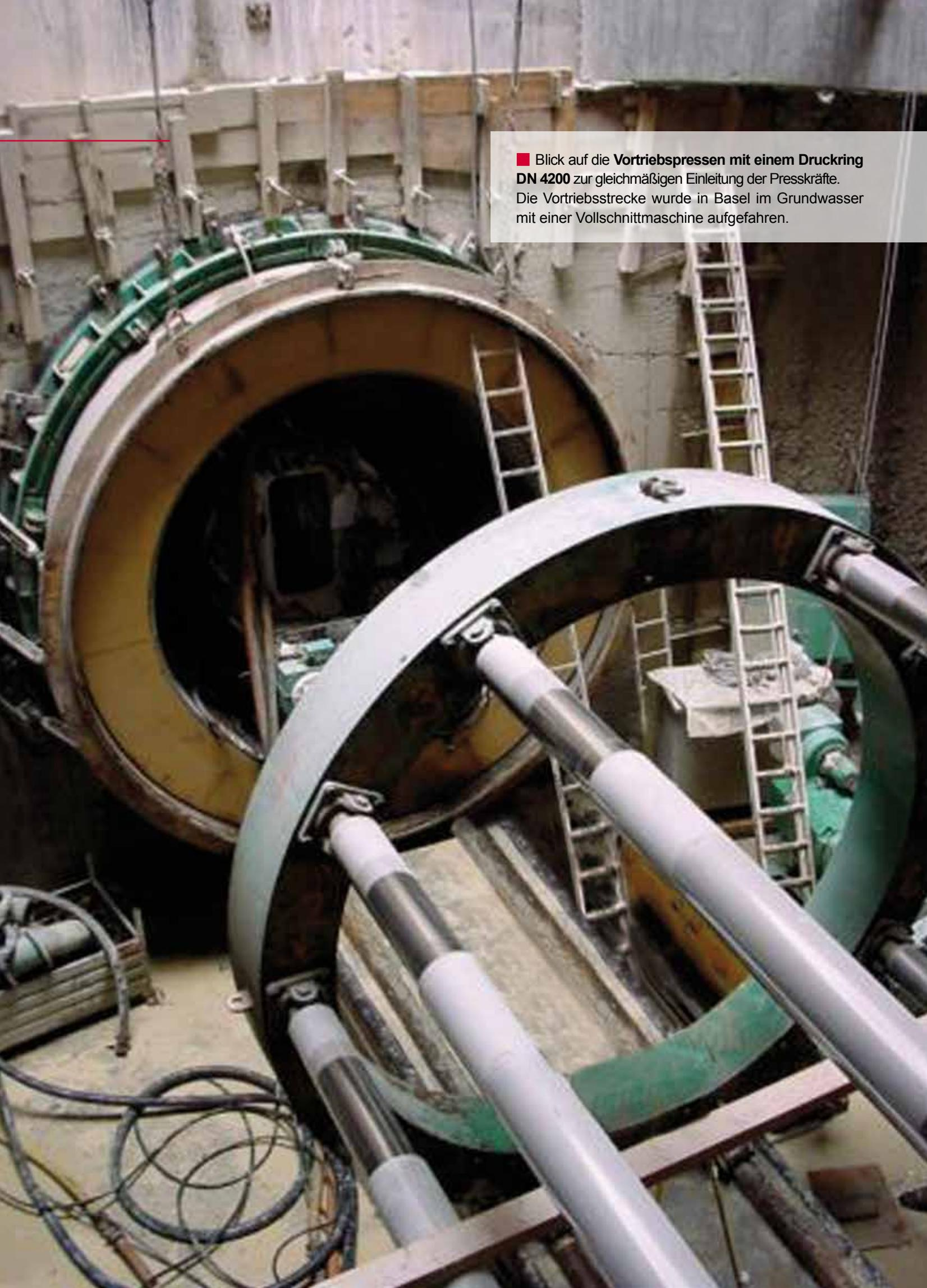
■ Blick auf die **Vortriebspresen** mit einem **Druckring DN 4200** zur gleichmäßigen Einleitung der Presskräfte. Die Vortriebsstrecke wurde in Basel im Grundwasser mit einer **Vollschnittmaschine** aufgeföhren.
