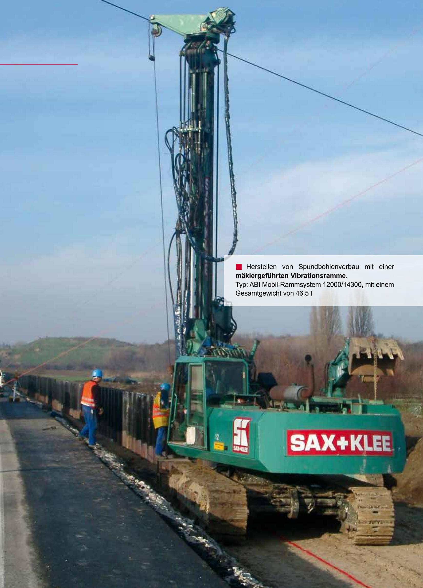
■ Herstellen von Spundbohlenverbau mit einer mäklergeführten Vibrationsramme.
