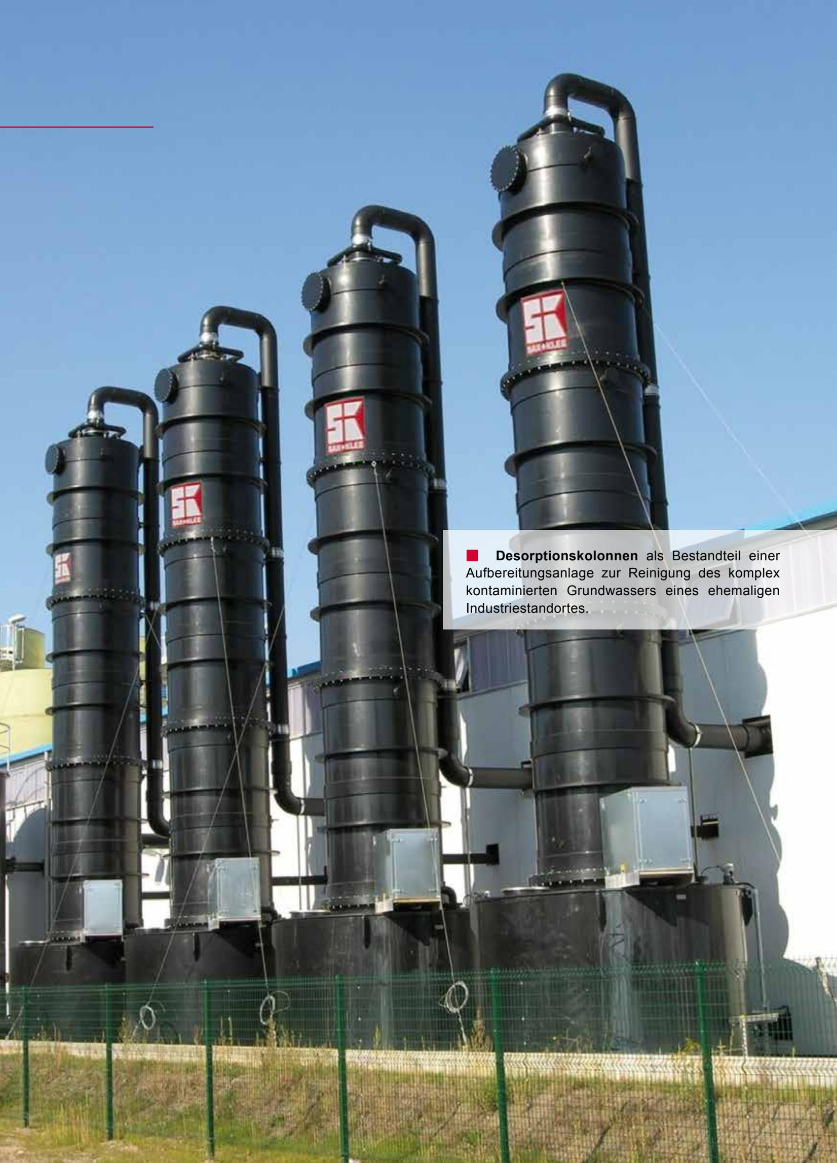
■ **Desorptionskolonnen** als Bestandteil einer Aufbereitungsanlage zur Reinigung des komplex kontaminierten Grundwassers eines ehemaligen Industriestandortes.
