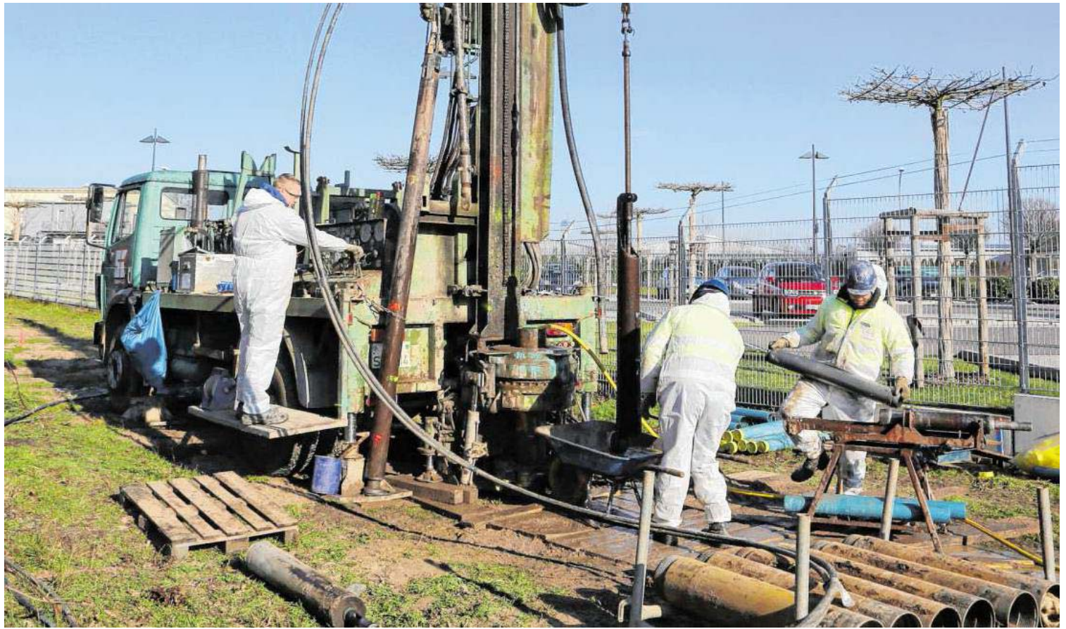
Argon Weiler (v.l.), Andreas Hampel und Kaya Bilal setzen Bohrungen im Umfeld des Maudacher Gewerbegebiets an der Frigenstraße.
